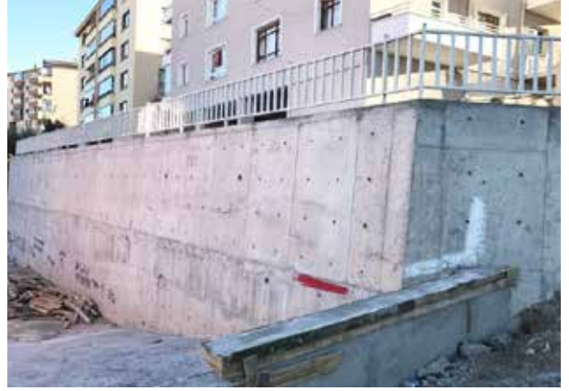
Güçlükaya Mahallesi İstinat Duvarı
