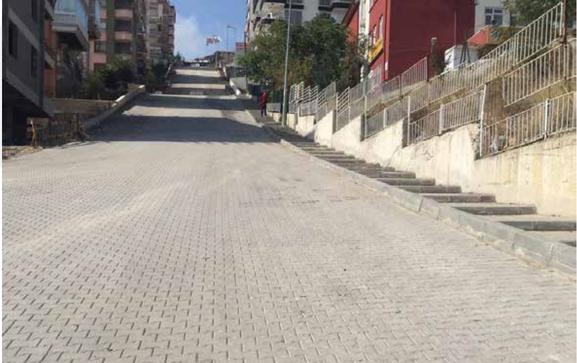
Sancaktepe Mahallesi 1592 Sokak Yol Kaplama Çalışması
