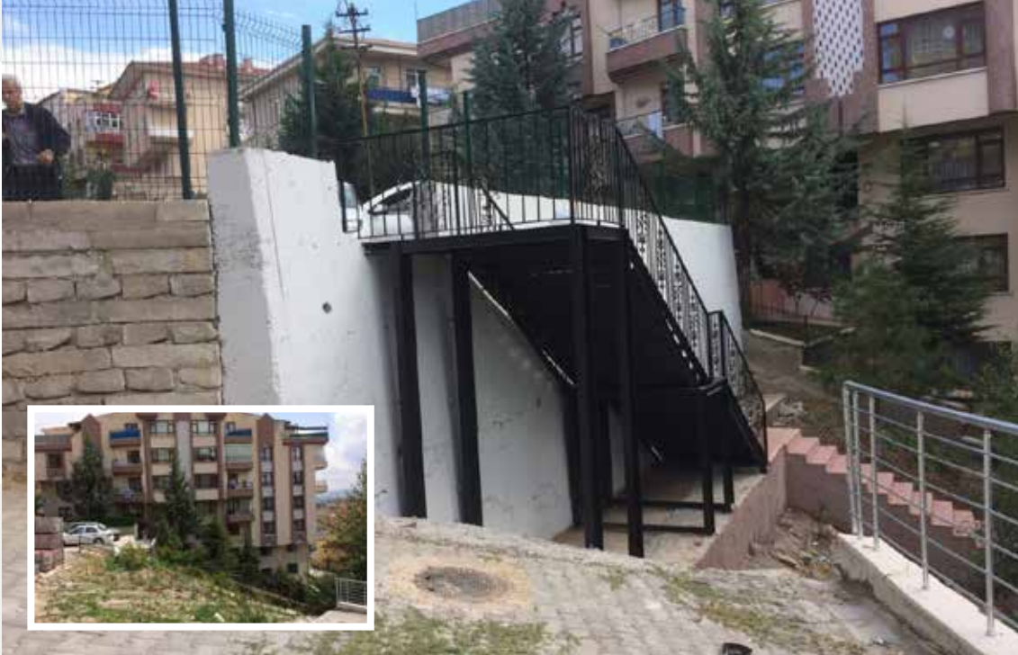
Bağlarbaşı Mahallesi Gamze Sokak İstinat Duvarı, Çelik Merdiven ve Betonarme Merdiven Yapımı
