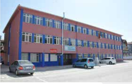
19 Mayıs İlkokulu Cephe Tadilatı ve Boyası
