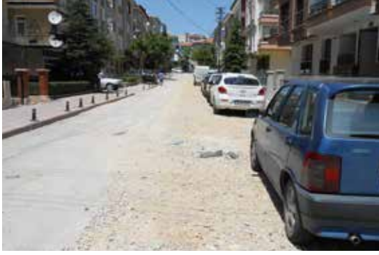
Kalaba Mahallesi Nişane Sokak – Eski Hali
